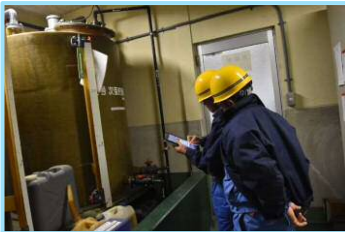
写真 3-8：水道施設の点検風景
