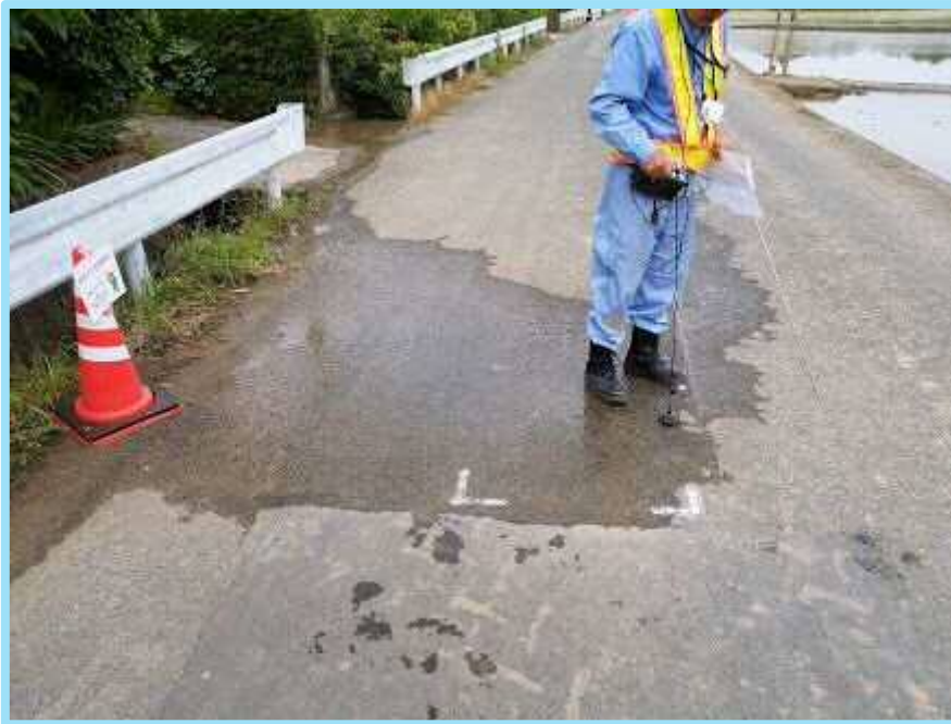
写真 3-9：専用の機器を使って漏水箇所を特定している風景
