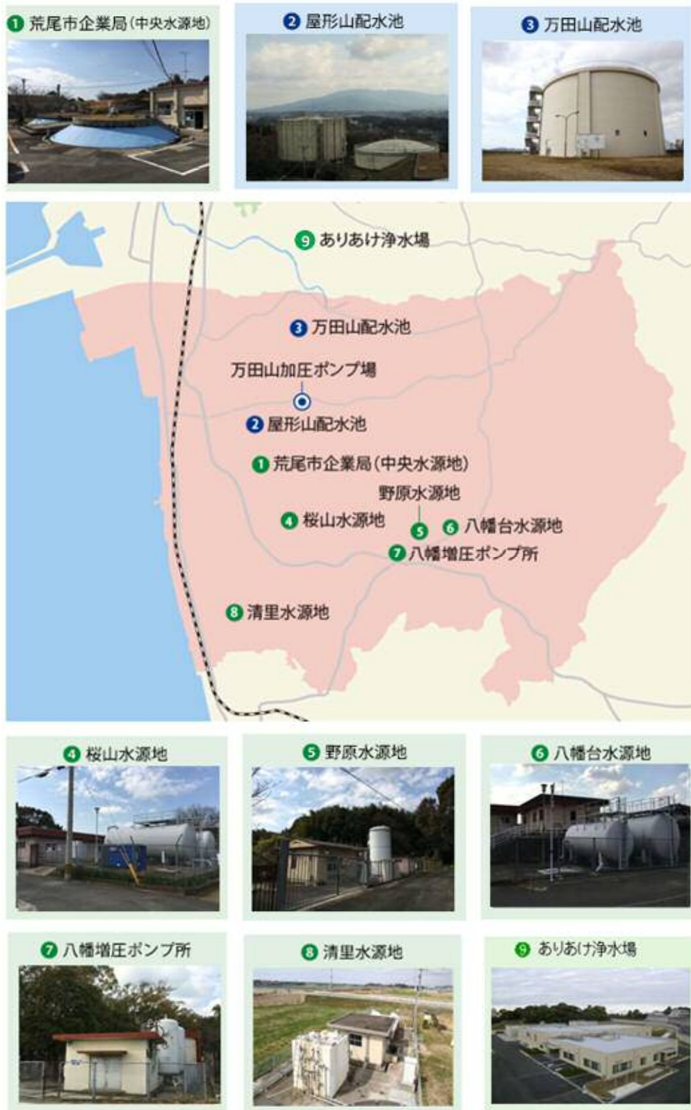
2-7 荒尾市の水道施設（あらおウォーターサービス㈱HP より）
